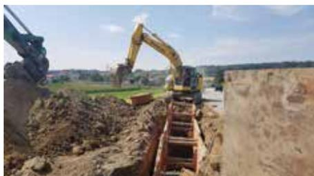
Die Infrastrukturbauarbeiten (Schmutzwasserkanal, Regenwasserableitung, Trinkwasserversorgung, Strom- und Glasfaserverlegung) schreiten zügig voran und sollen im Oktober/November 2020 abgeschlossen werden. Der Großteil der Bauparzellen sind erfreulicherweise bereits verkauft bzw. der erste Rohbau wurde bereits errichtet. Bei drei
